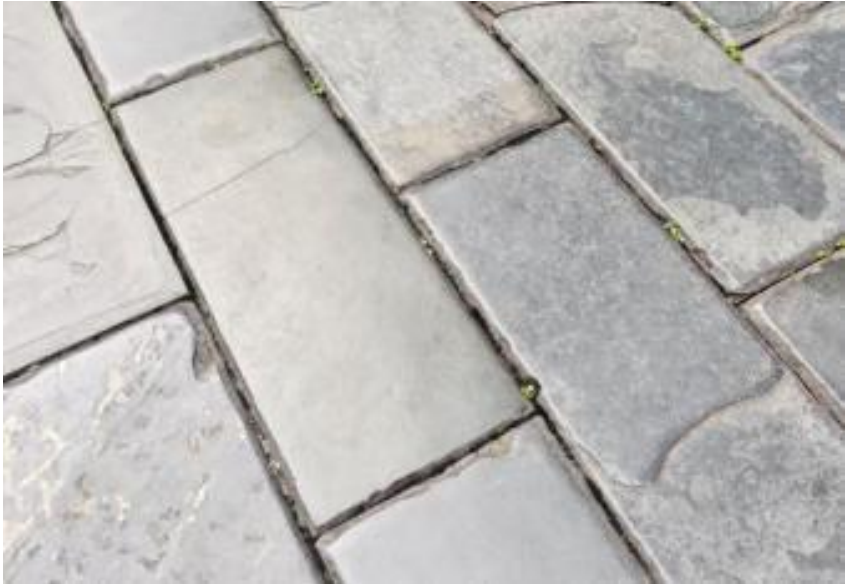
更换后地面铺装材质
