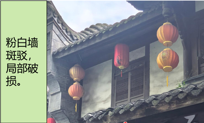
封檐板脱漆 糟朽，瓦当 滴水局部缺 失，屋面瓦 件有滑落隐 患。
