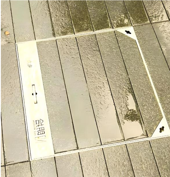
方案一：隐形井盖，盖顶放置和街道铺装同材质石材——铜板石
