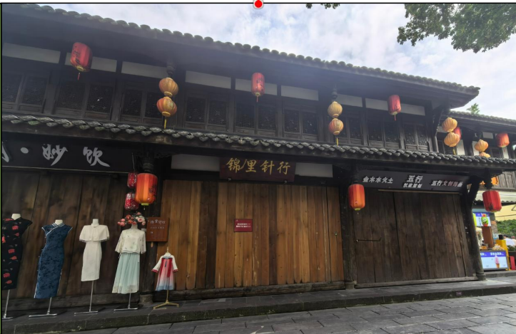
铺板门规制、 颜色及材质 不统一，地 脚枋规格不 统一，破坏 古街风貌。
